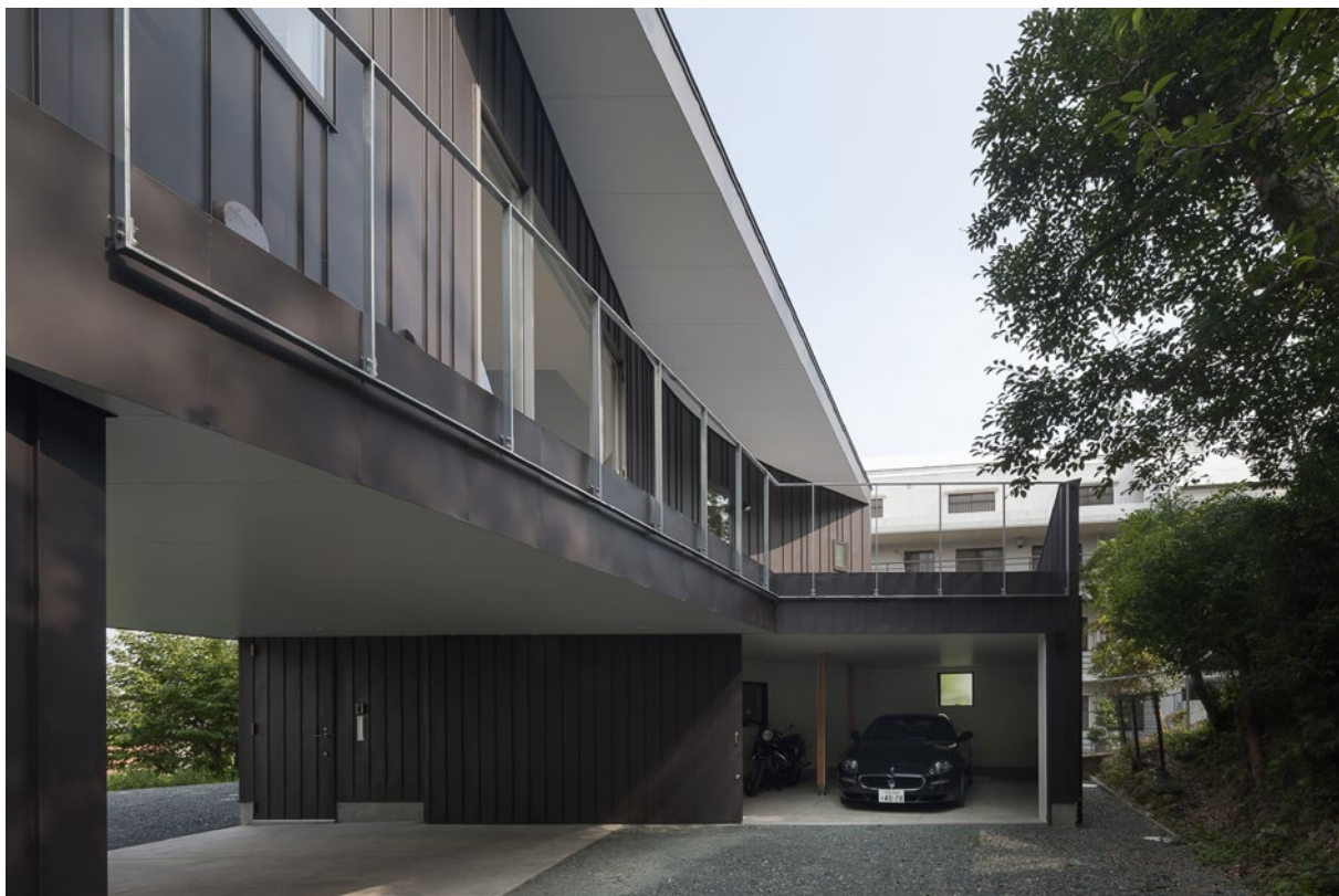
1 階のピロティは車路でもあり、来客時のガレージにもなる
