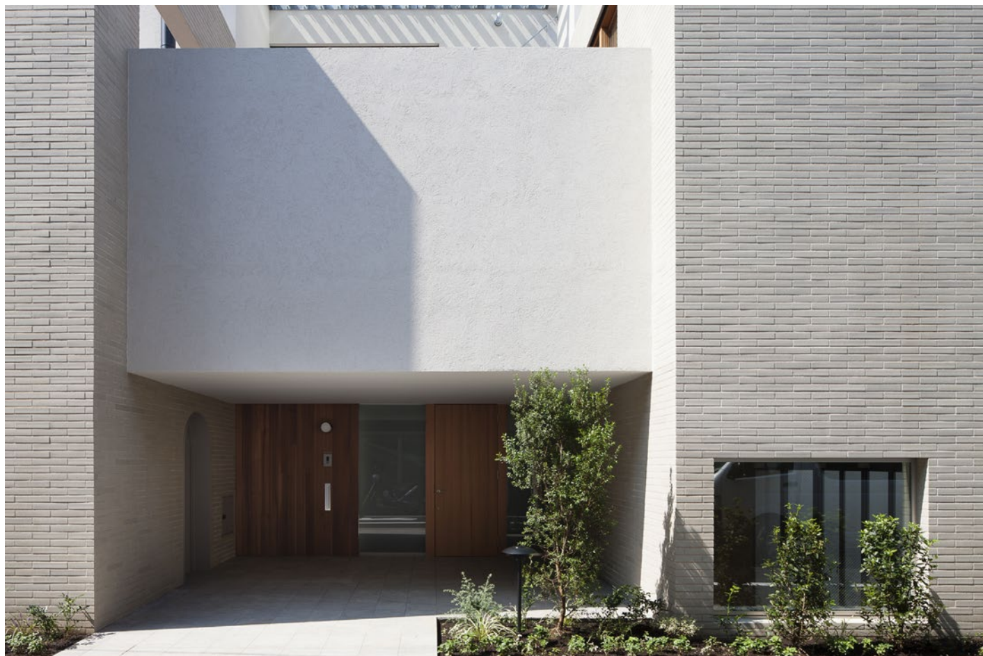
道路に面する玄関ポーチ
