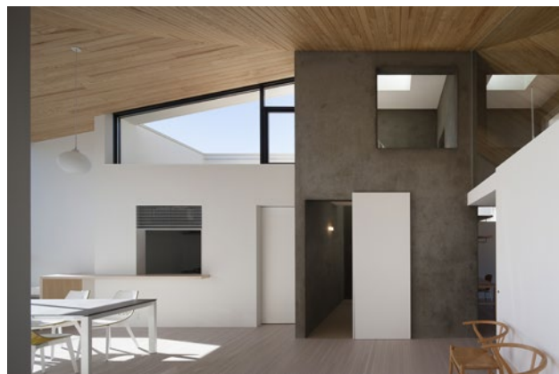
中央の樹脂モルタルのコアが階段ギャラリー / 板張りの屋根が集まる
